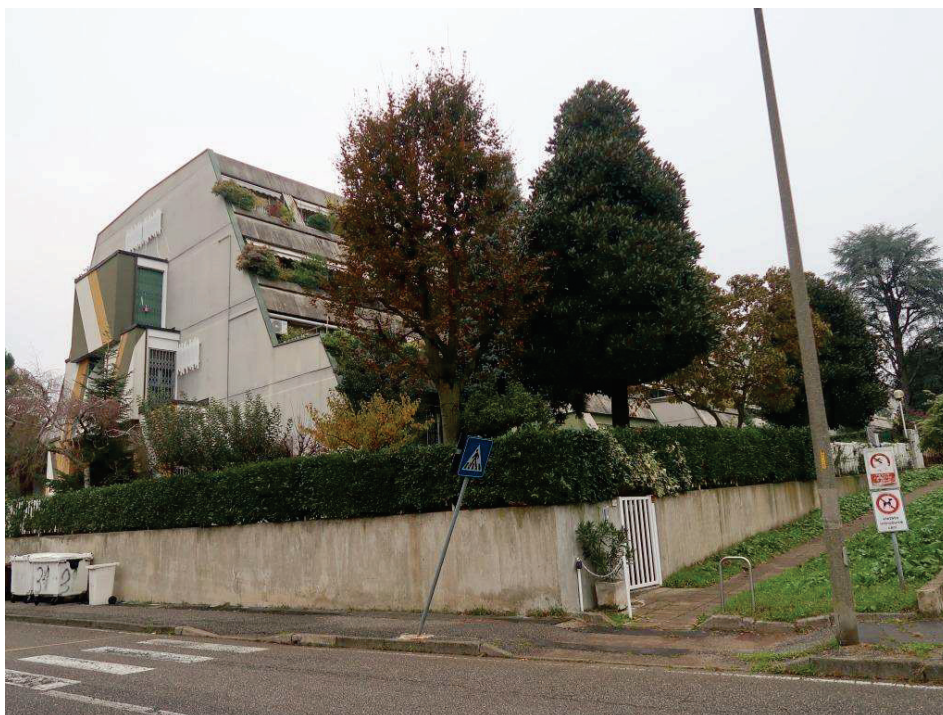
FACCIATA SU VIA AMENDOLA E INGRESSO PEDONALE
